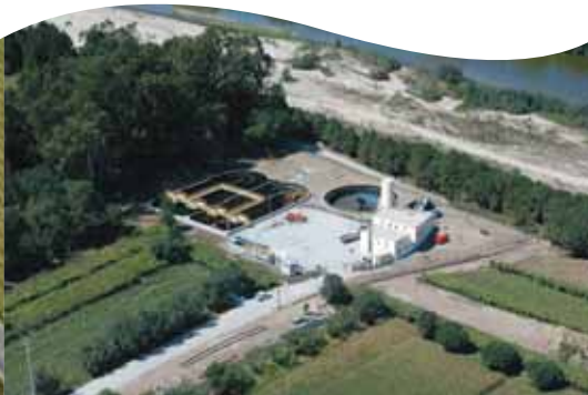
ETAR de Ponte de Lima
